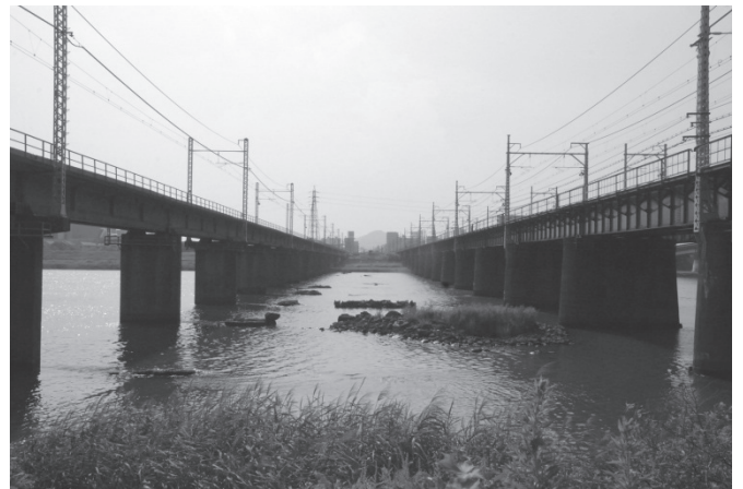
現存する震災で崩壊した馬入川鉄橋の脚台
